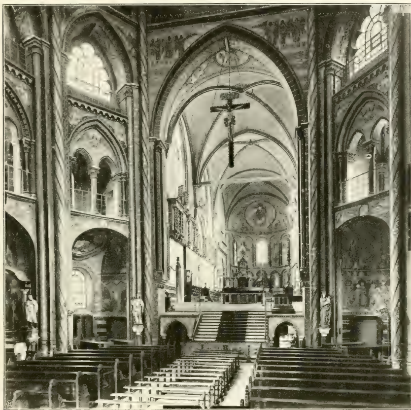
Intérieur de l'église Saint-Géréon.
